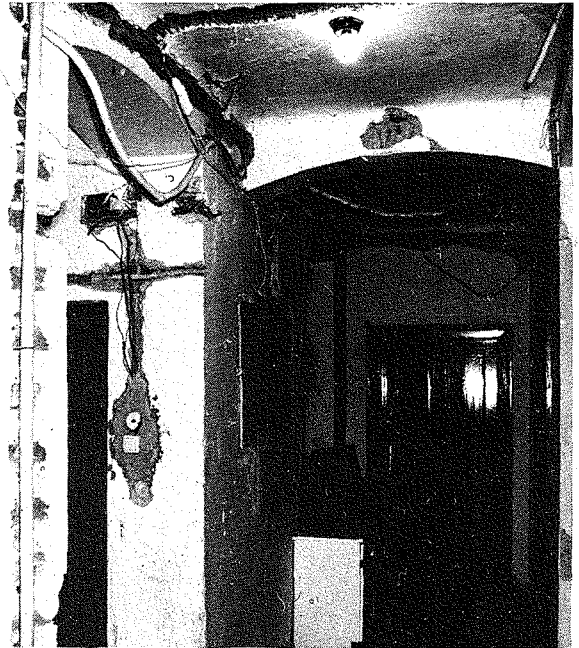
Innenansicht des "sanierten" Hauses in der Arbeitergasse
